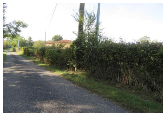
Taille sur le dessus justifiée par la présence de réseaux aériens
